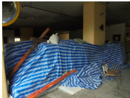
4-11 ใช้ผ้าปิดคลุมวัสดุที่จะทำให้เกิดฝุ่นละออง เช่น ปูนซีเมนต์ชนิดผง
