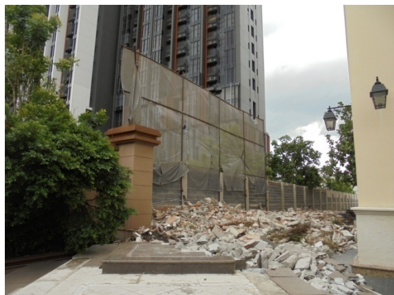
4-17 รื้อถอนรั้วเดิมบางส่วนเพื่อสร้างใหม่และกันสแลตเพื่อป้องกันผลกระทบด้านฝุ่นละออง
