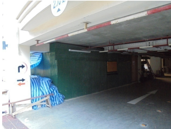
4-10 มีห้องเก็บวัสดุ อุปกรณ์ก่อสร้าง เป็นห้องปิดป้องกันฝุ่นฟุ้งกระจาย
