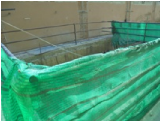
4-29 หลุมลึก ทำราวกันตกล้อมรอบ และมีสแลนปิดกัน
