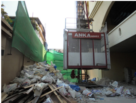
4-7 บริเวณรอบลิฟต์ชั้นของ ปิดสแลนป้องกันฝุ่นละอองไว้ด้านที่ติดกับอาคารข้างเคียง ปัจจุบันนำลิฟท์ออกแล้ว
