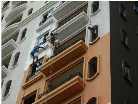
4-25 สวมใส่อุปกรณ์ขึ้นที่สูง เพิ่มขีดนิรภัยในการทำงานที่สูง
