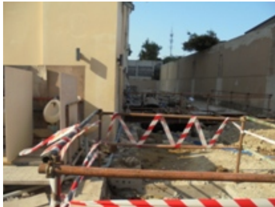
4-29 หลุมลึก ทำราวกันตกล้อมรอบ และมีสแลนปิดกัน
