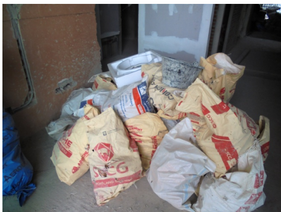
4-9 เศษวัสดุก่อสร้างที่มีฝุ่นละออง เช่น เศษปูนที่ทุบผนัง ใส่ถุงปิดคลุมไว้เพื่อไม่ให้มีฝุ่นฟุ้งกระจาย
