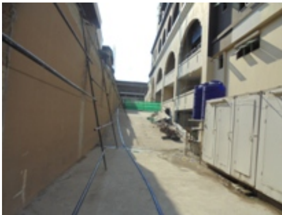
4-17 รื้อถอนรั้วเดิมบางส่วนเพื่อสร้างใหม่และกันสแลตเพื่อป้องกันผลกระทบด้านฝุ่นละออง
