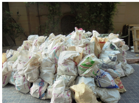
4-9 เศษวัสดุก่อสร้างที่มีฝุ่นละออง เช่น เศษปูนที่ทุบผนัง ใส่ถุงปิดคลุมไว้เพื่อไม่ให้มีฝุ่นฟุ้งกระจาย
