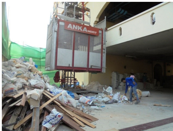
4-5 ติดตั้งลิฟต์ขนส่งของไว้ด้านทิศตะวันออกของอาคาร
