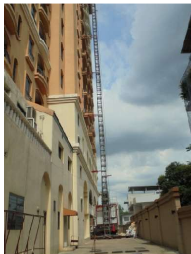
4-20 ลิฟต์ขนส่งของเพื่าค้ำความสูงของอาคาร ปัจจุบันนำออกแล้ว
